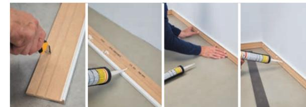
NL Pas de hoogte aan met een breekmes. Plaats de plinten en verzaag de vloerpanelen in stroken. Deze stroken klik je in elkaar aan de korte zijden en lijm je vast in de plint. Geschikt voor LVT tot 6mm - laminaat tot 10mm.
