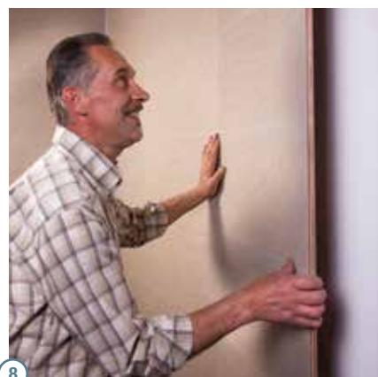
Voorzie in elke verticale voeg (in de profiling) sanitaire silicone om deze waterdicht te maken. Laat de overtollige silicone opdrogen. Als deze droog is, kan je dit met een scherp mesje weg snijden.
