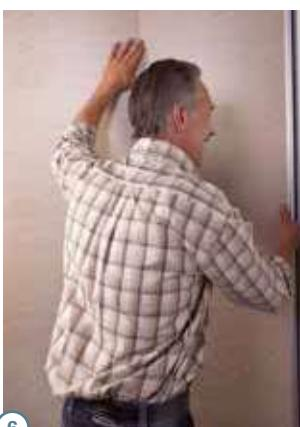
Bevestig het hoekprofiel op het paneel alvorens dit te plaatsen. Vergeet de sanitaire silicone niet!
