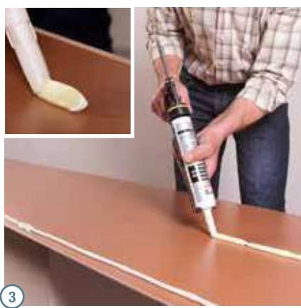
Werk met de klok mee. Breng een elastische, sterke montagelijm\*\* aan op de achterzijde van het paneel: 3 lijmstrengen in de lengte richting van de plaat. Plaats het paneel tegen de wand en druk goed aan.
