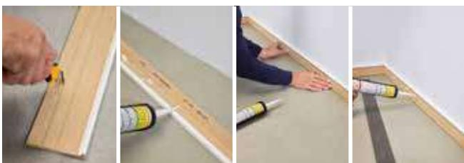
**NL** Pas de hoogte aan met een breekmes. Plaats de plinten en verzaag de vloerpanelen in stroken. Deze stroken klik je in elkaar aan de korte zijden en lijm je vast in de plint.
