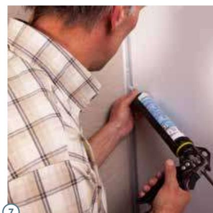
In de nog vrije hoek wordt het profiel bevestigd tegen de muur. Breng opnieuw silicone in het profiel, zaag de groef van het eerste paneel dat in het profiel moet en werk verder.
